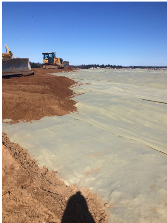
Рисунок 4 – Слой геотекстиля и грунта.
